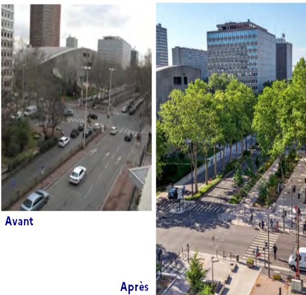
Figure 28: La rue Garibaldi (Lyon) avant et après aménagement
