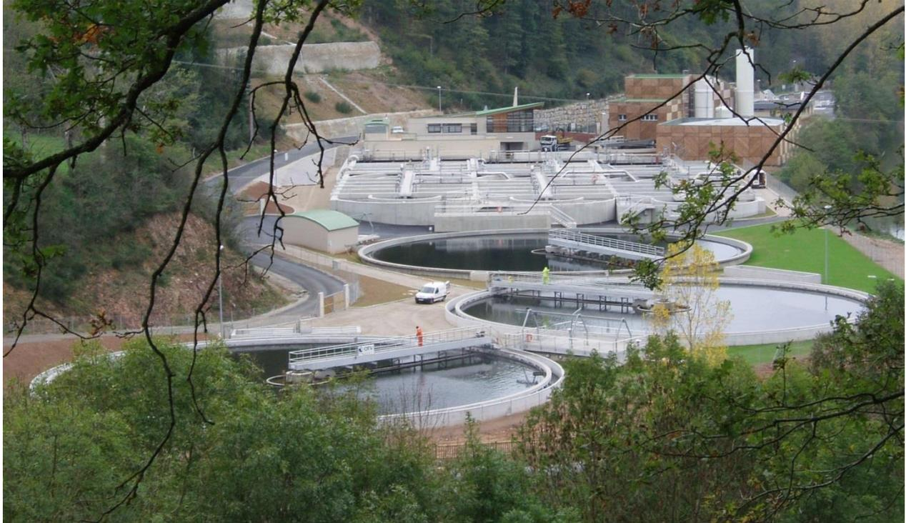
La capacité hydraulique maximale de l'usine est de **2 100 m<sup>3</sup>/h**.
